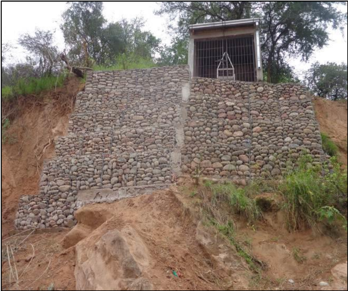
Fotografía N° 1: estado casilla de aforo, año 2015
