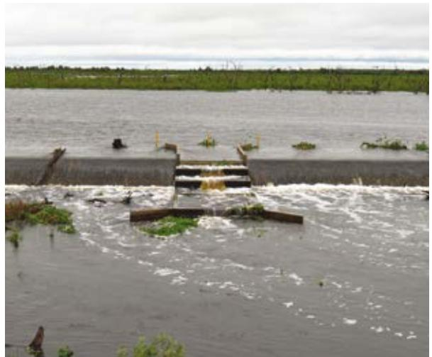
**VERTEDERO:** construcción que permite el paso del agua.
