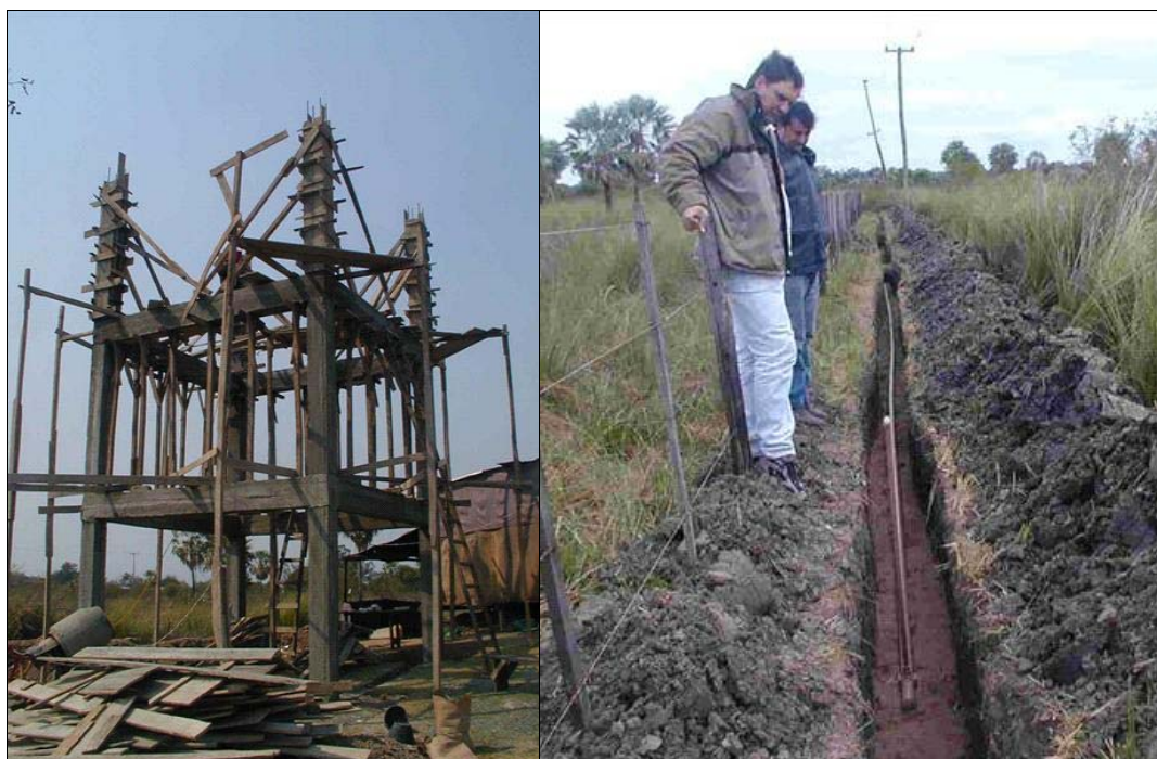
Construcción de tanque de almacenamiento de 30.000 lts. en Gral. Bruguez. Colocación de tuberías a la red principal de agua potable.
