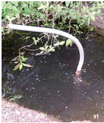
91: Vista detalle de pozo abandonado.
