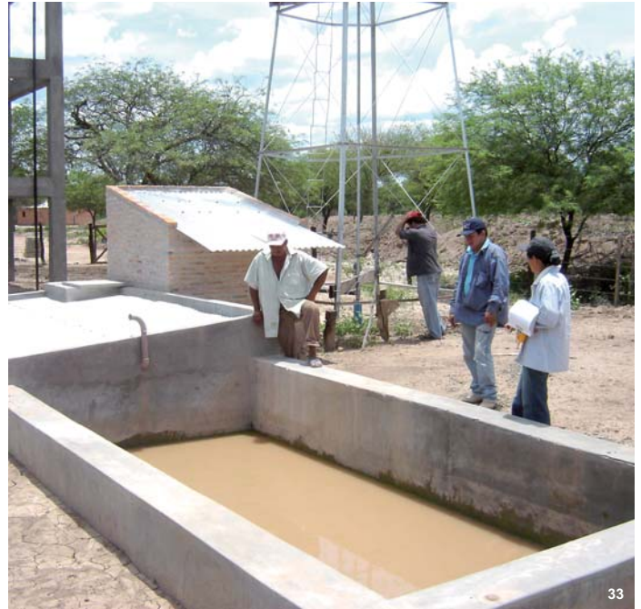
32: Tanque de almacenamiento con capacidad para 30.000 lts. de agua.
