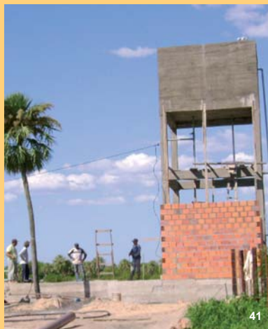
40, 41: Tajamar nuevo, lleno por el agua de las lluvias de enero. Vista de la construcción del tanque y caseta de bombeo, en la comunidad de Gral. Bruguez.
