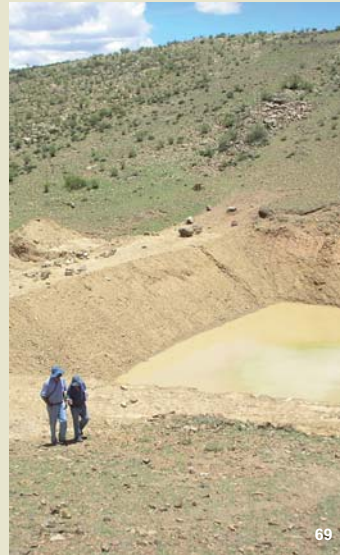
69 : Atajado acondicionado para el almacenamiento de agua de lluvia. Jatún Khakha. Yamparáez. Chuquisaca.
