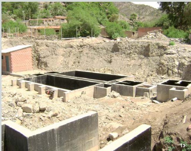
13: Planta de tratamiento de agua potable a continuación de los humedales, sistema de filtros lentos de arena concluidos.
