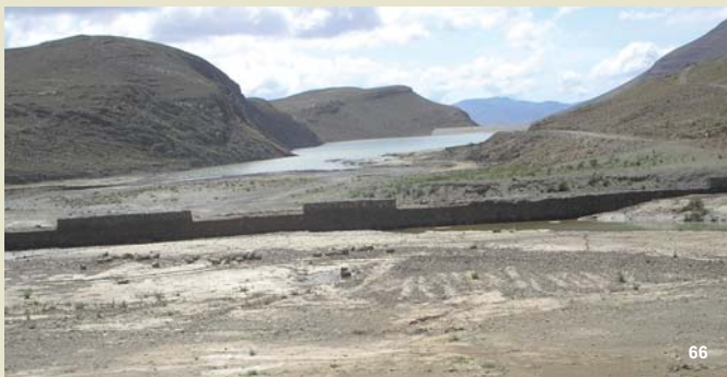
66: Construcción de gaviones y terrazas orientados a la retención de sedimentos. El Terrado. Chuquisaca.
