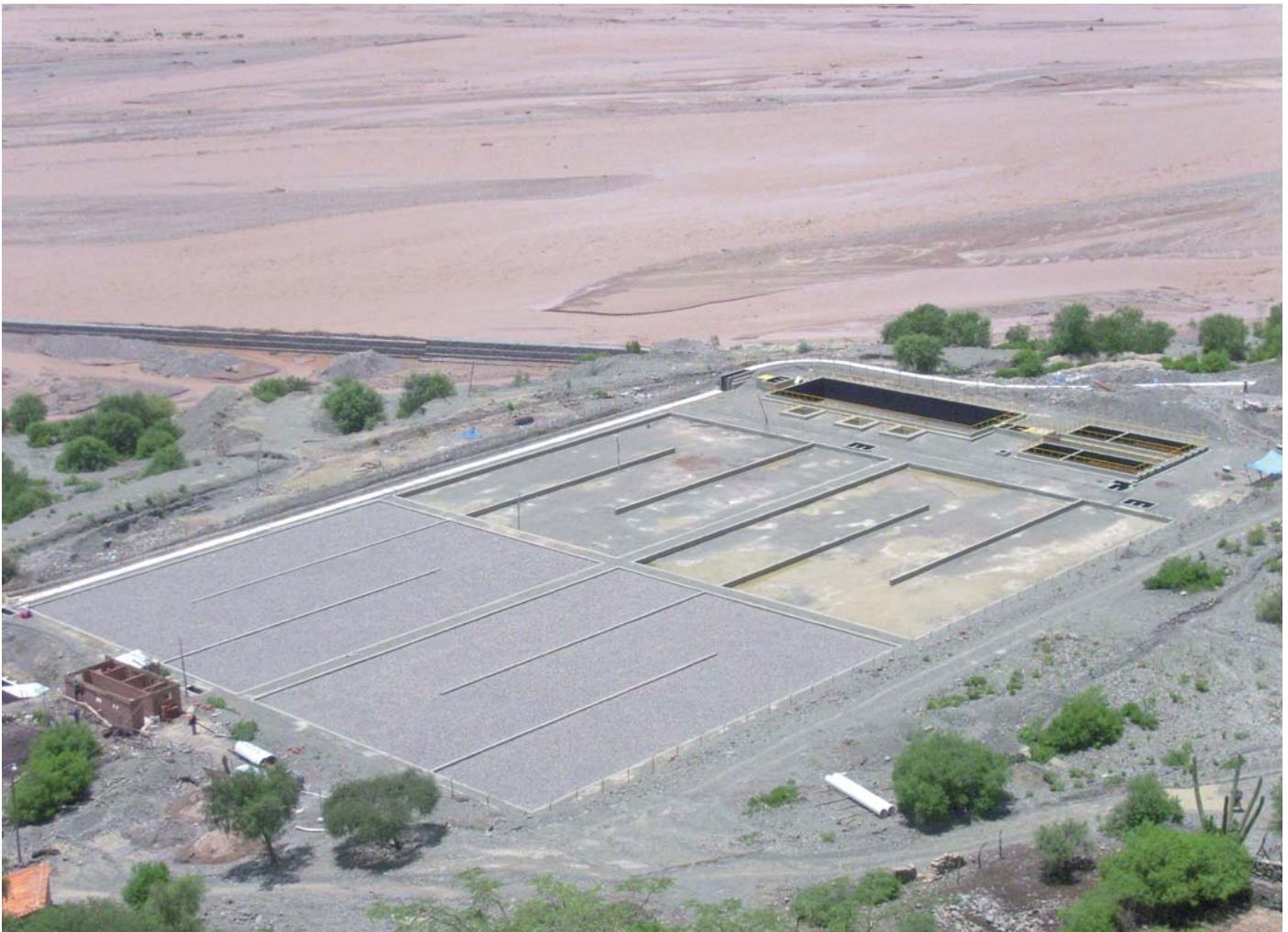
Vista panorámica de la Planta de Tratamiento de Agua. Al fondo, el río Pilcomayo.
