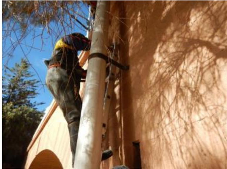
**Fotografía 8. Tubería de instalación de la sonda.**
