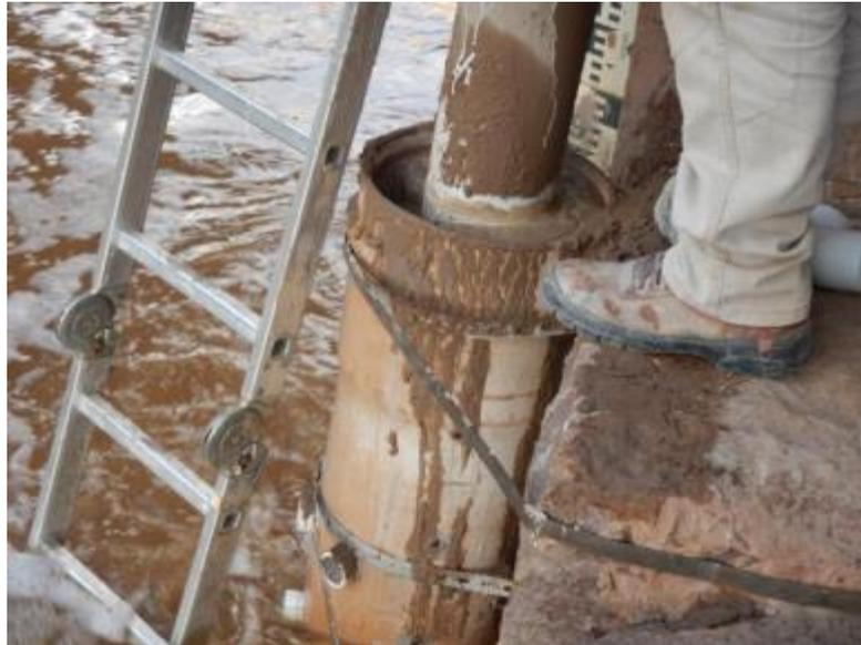
**Fotografía 9. Vaciado de cemento entre los tubos concéntricos.**
