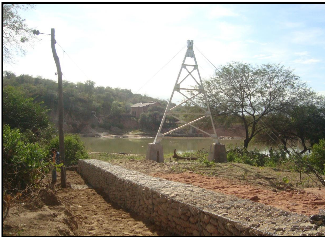
Fotografía N° 1: Sección de aforo (vista desde margen derecha)
