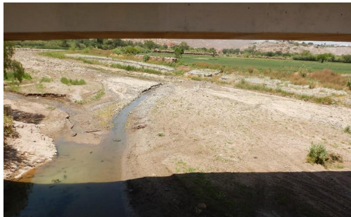
Fotografía 4. Río San Juan del Oro en El Puente – aguas arriba del puente
