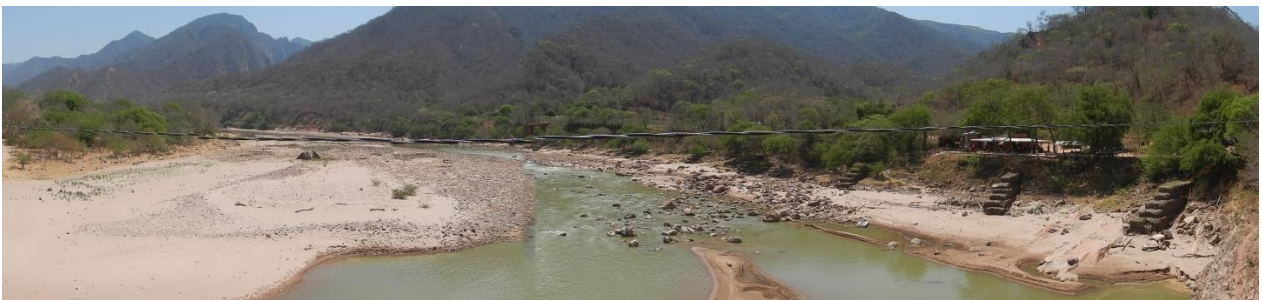
Fotografía 22. Río Pilcomayo en Villa Montes – aguas arriba del puente
