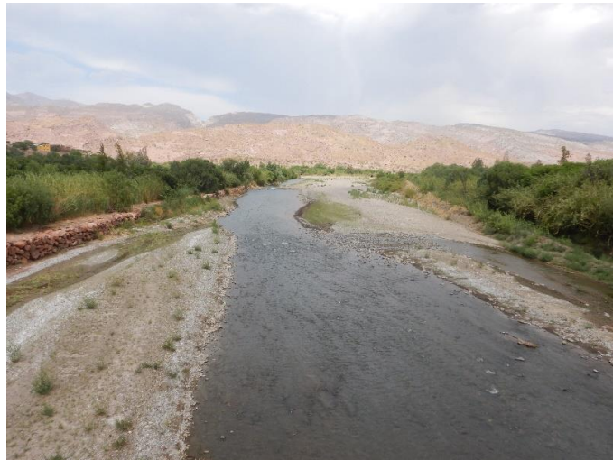
Fotografía 2. Río Tumusla en Palca Grande – aguas abajo del puente carretero
