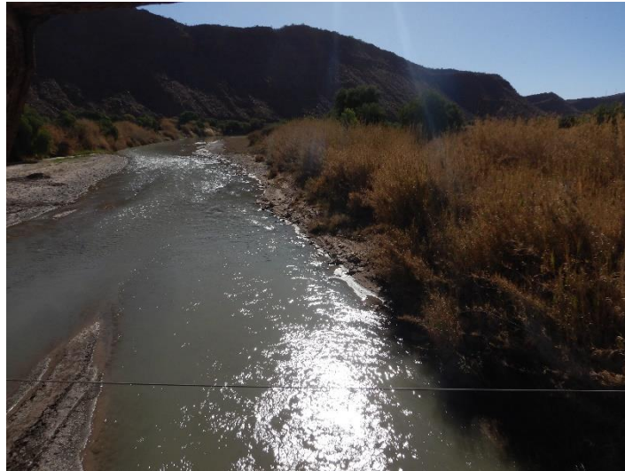
Fotografía 14. Río San Juan del Oro en El Puente – aguas abajo del puente
