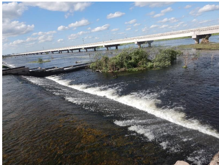
Fotografía 49. Bañado La Estrella – aguas abajo de la antigua ruta 28 se puede ver el puente que ahora cruza el vertedero
