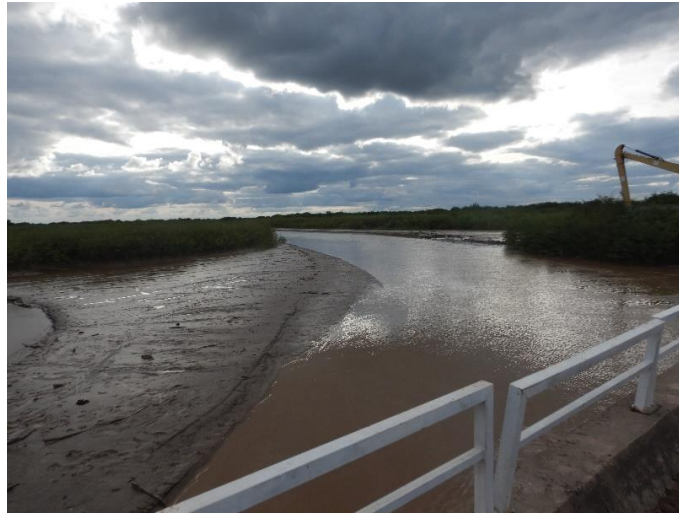
Fotografía 64. Canal Paraguayo en General Díaz – aguas arriba del puente
