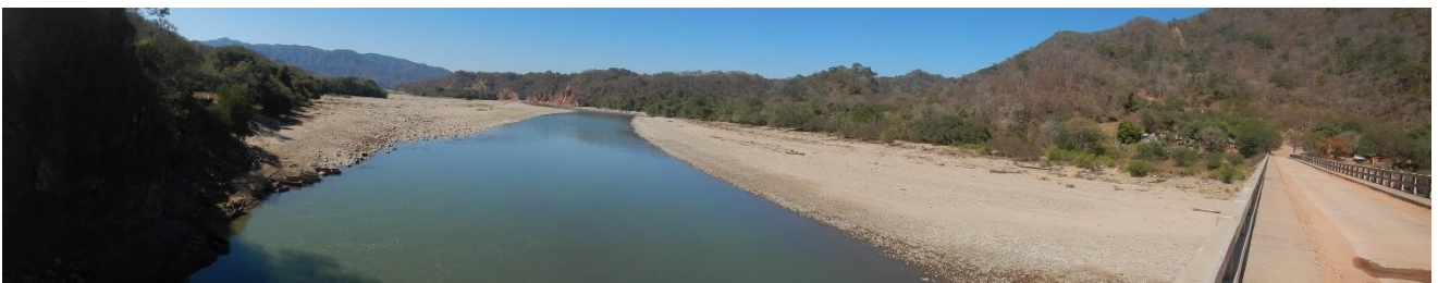
Fotografía 39. Río Pilcomayo en Puente Aruma – aguas abajo del puente
