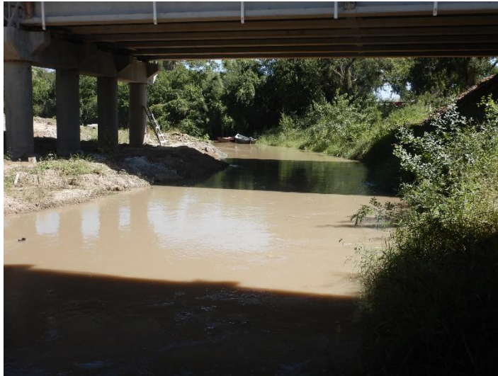
Fotografía 81. Río Negro en ruta PY09 – Vista del puente carretero hacia aguas arriba
