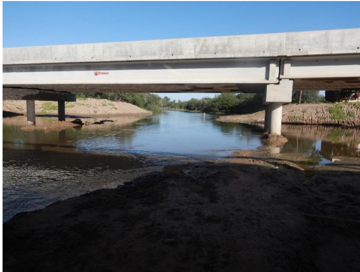
Fotografía 85. Río Verde – vista aguas arriba del puente
