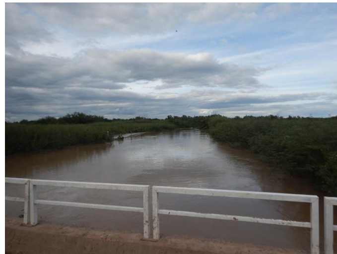
Fotografía 65. Canal Paraguayo en General Díaz – aguas abajo del puente
