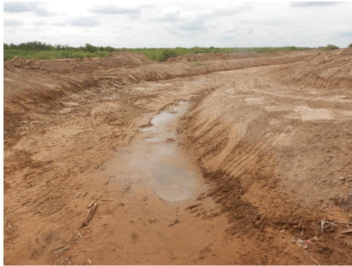
Fotografía 10. Pilcomayo en General Díaz – aguas abajo del puente
