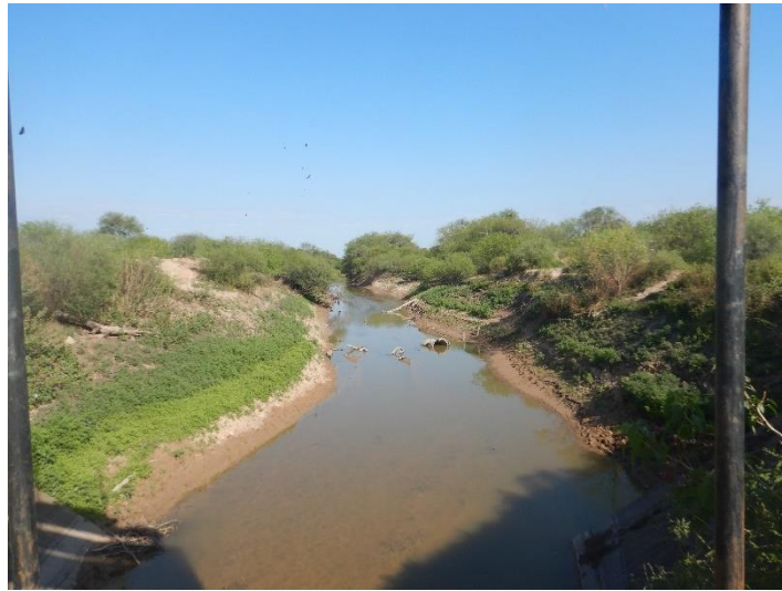
Fotografía 35. Salida Laguna Salada – Vista aguas arriba de la estructura
