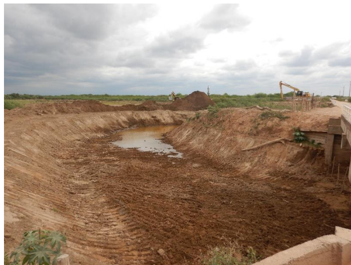
Fotografía 9. Pilcomayo en General Díaz – aguas arriba del puente
