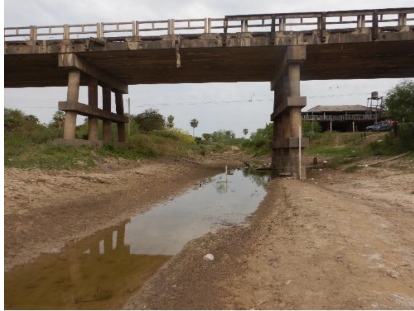
Fotografía 19. Río Montelindo – aguas arriba del punto de muestreo
