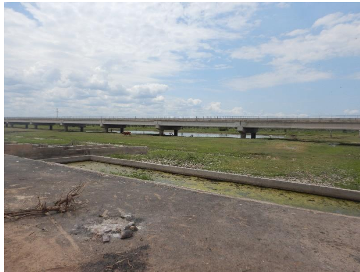
Fotografía 34. Bañado La Estrella – aguas abajo de la antigua ruta 28 se puede ver el puente que ahora cruza el vertedero
