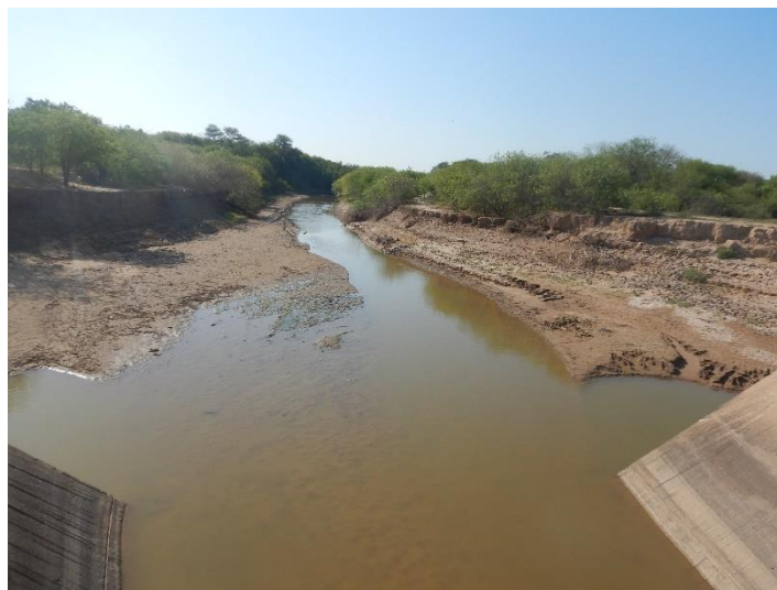
Fotografía 36. Salida Laguna Salada – Vista aguas abajo de la estructura
