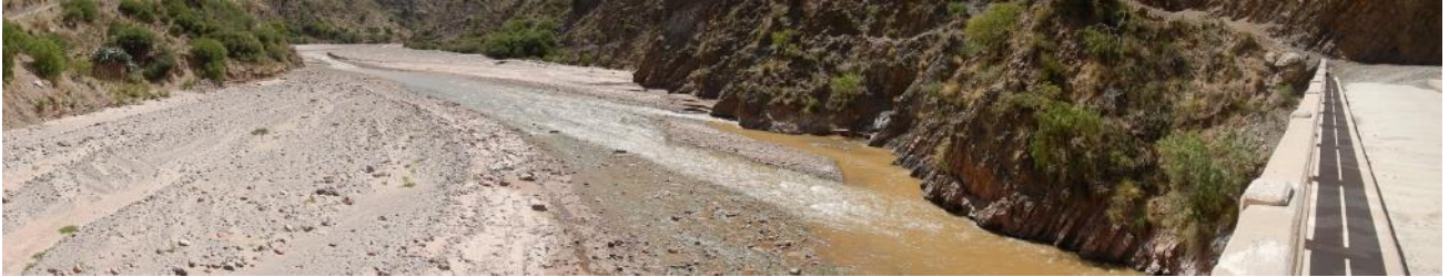
Foto 11. Río Pilcomayo antes de la unión con el río Tacobamba (Aguas arriba del puente carretero)
