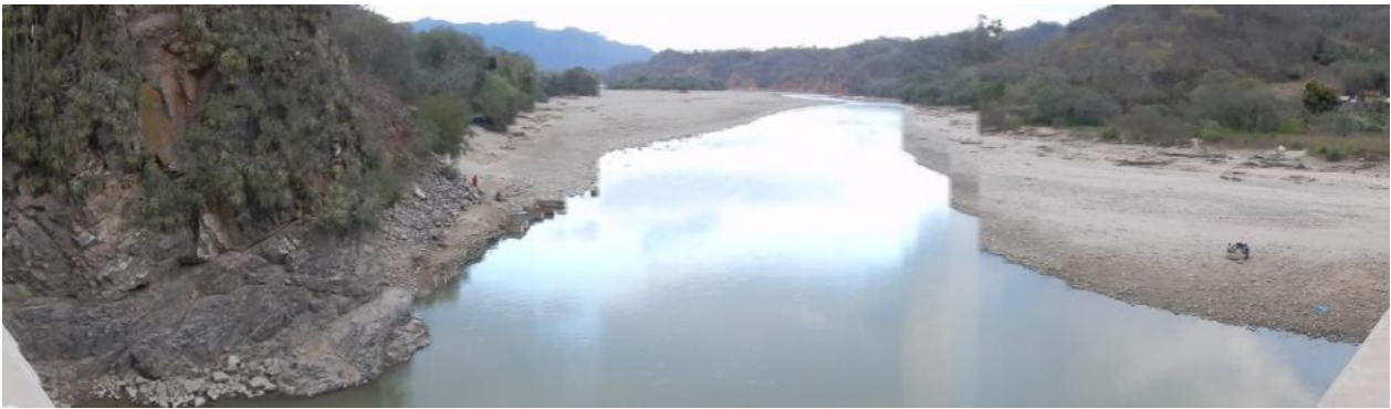
Fotografía 32. Río Pilcomayo – aguas abajo del puente
