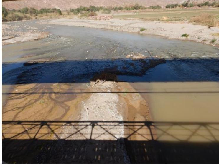
Fotografía 16. Río San Juan del Oro en El Puente – aguas arriba de puente carretero
