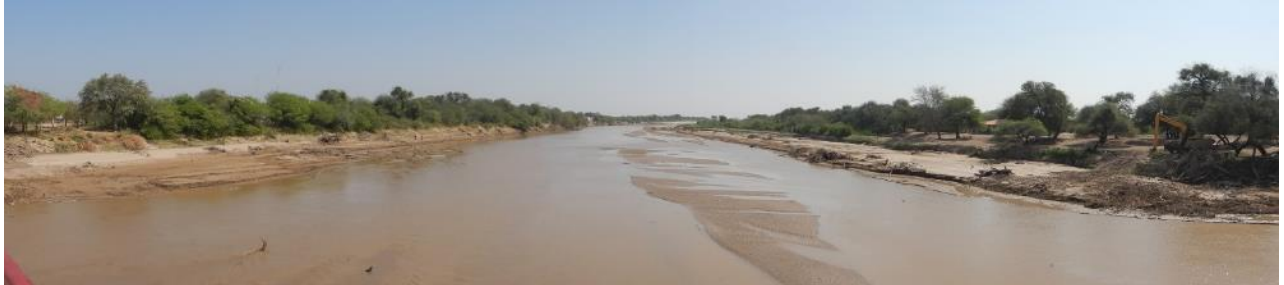
Fotografía 1. Misión La Paz/Pozo Hondo – Aguas arriba del puente internacional
