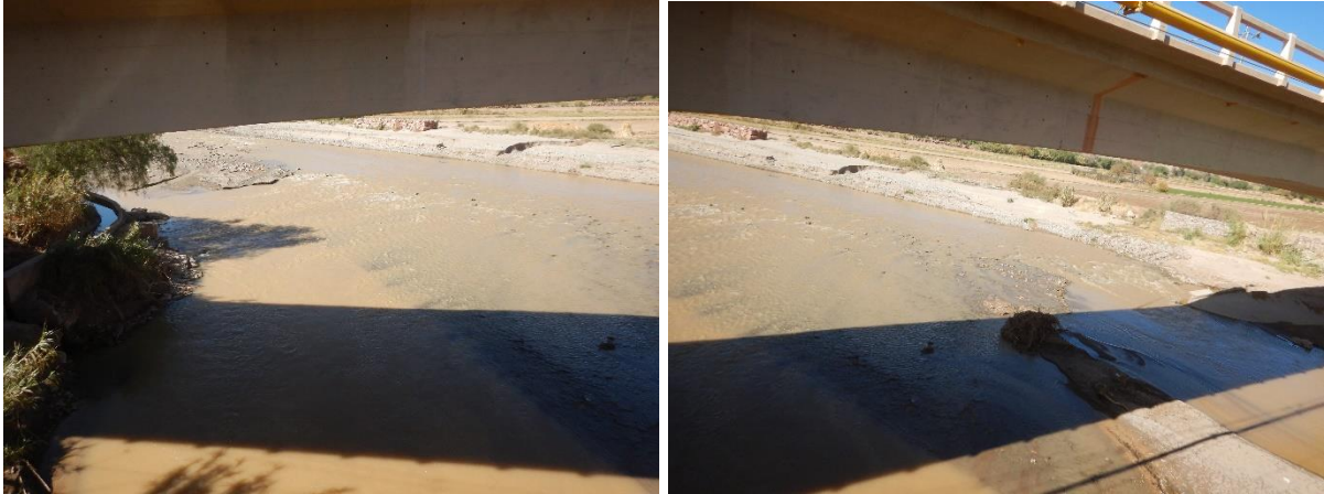
Foto 13 (a y b). Río San Juan del Oro (El Puente) - Aguas arriba
