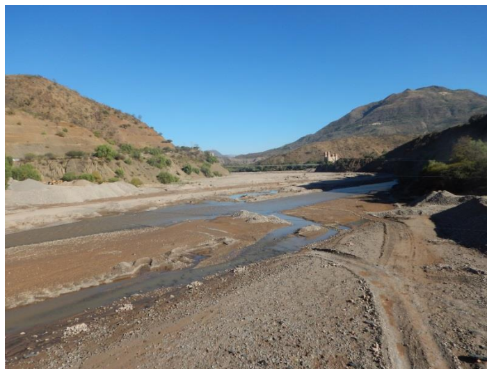
Foto 32. Río Pilcomayo – Puente Mendez (aguas arriba)
