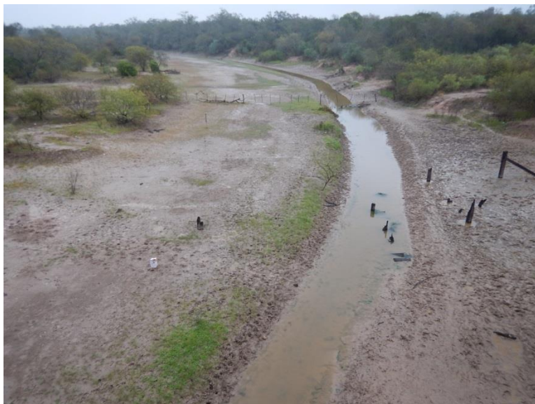
Foto 50. Aguas arriba – Río Montelindo
