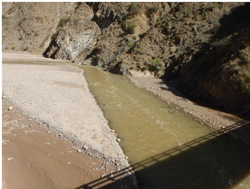
Foto 30. Río Pilcomayo – Aguas arriba del puente.
