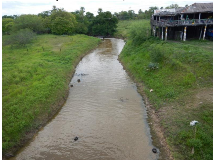
Foto 60. Río Montelindo, aguas arriba del puente carretero.
