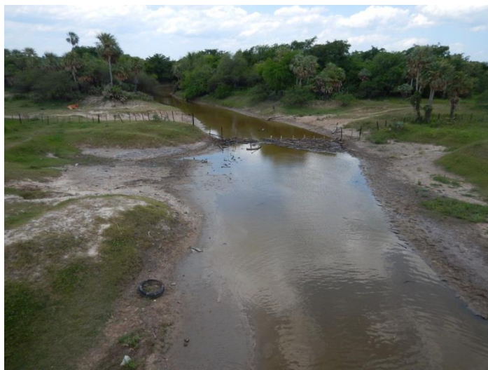
Foto 61. Río Montelindo, aguas abajo del puente carretero.
