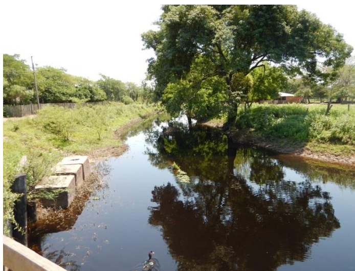
Foto 64. Río Confuso – aguas arriba del puente de madera.
