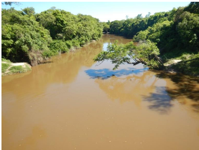
Foto 52. Riacho Montelindo, vista aguas arriba del puente carretero.
