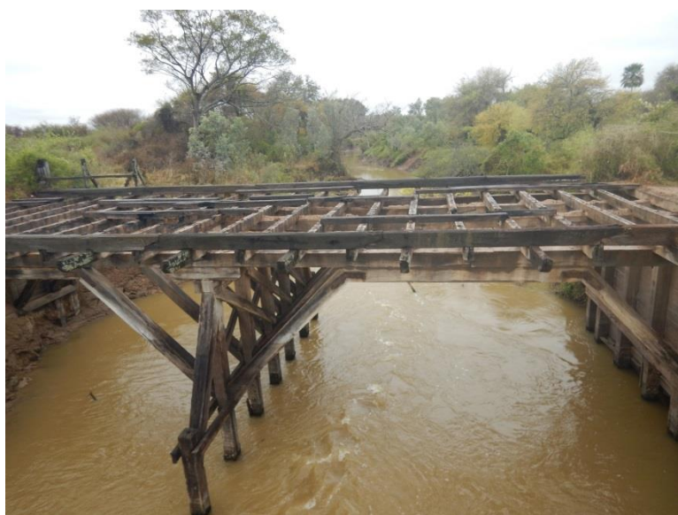
Foto 49. Aguas abajo – Puente sobre ruta 24
