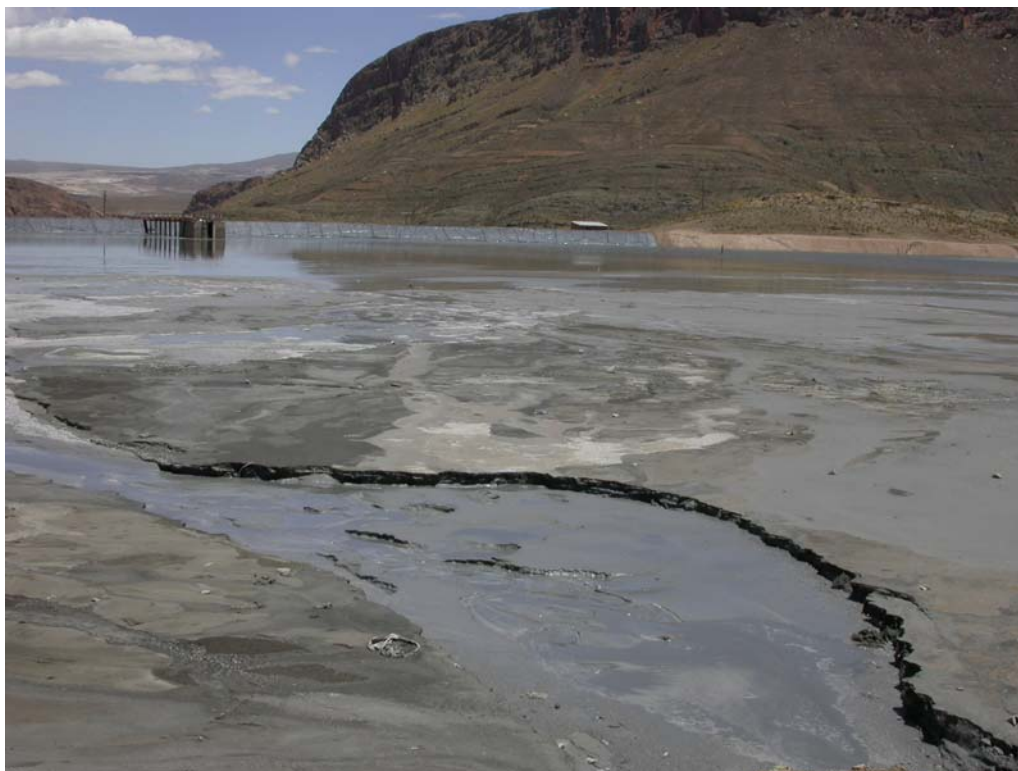
Figura 2: El dique de laguna Pampa
