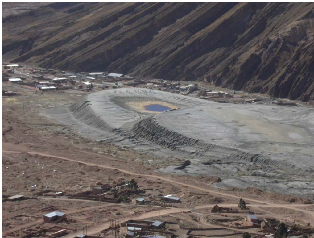
Figura 5: Desmonte de San Antonio en Potosí con pozas de aguas ácidas
