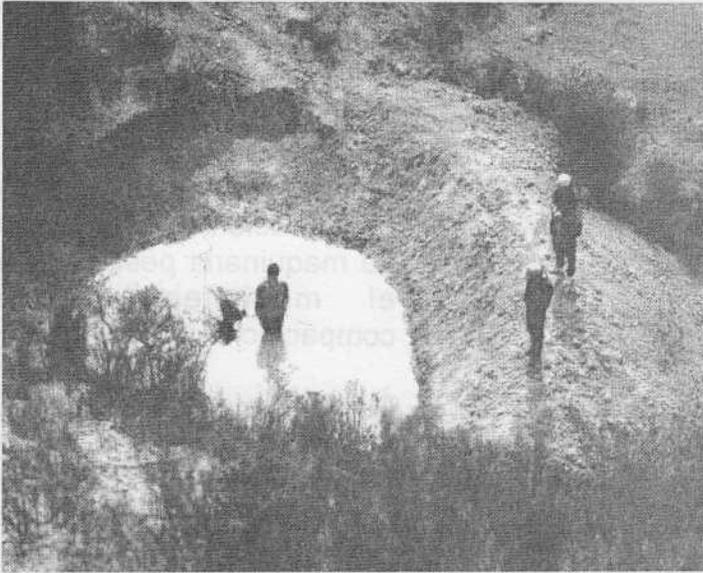
El tipo excavado construido en superficies cóncavas naturales, donde el agua se reúne naturalmente. La cortina se construye con tierra homogénea, conseguida al excavar manual o mecánicamente el área del vaso de almacenamiento. En lugares planos la cortina tiene forma de media luna, brazos alargados o forma circular. En cárcavas o ríos pequeños, se pueden construir batería de reservorios interconectados de diferente tamaño.
