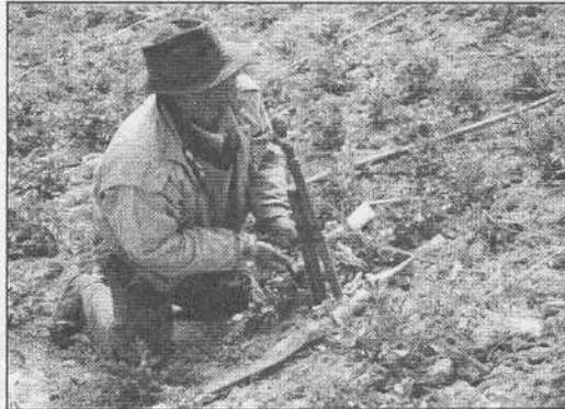
**Figura 14. Agricultor instalando y fijando el porta aspersor de acuerdo a la pendiente**
