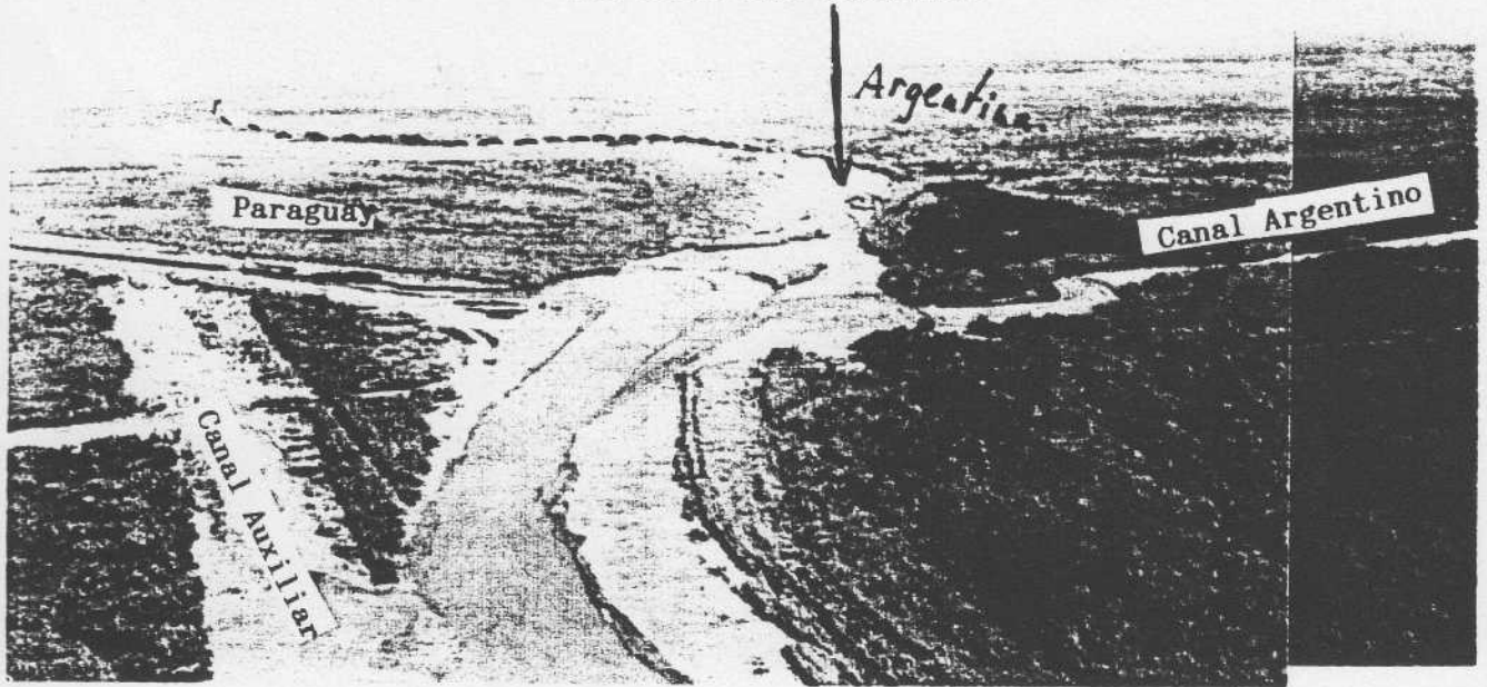
FOTO 5.1 Situación taponamiento, setiembre 1995 Canal Auxiliar en el lado Paraguayo, y el Canal Argentino están colmatados.
