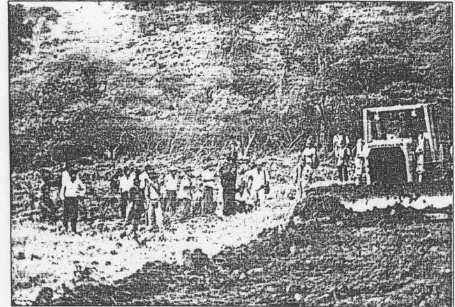
Foto 8. Desbrozo de la capa superficial
