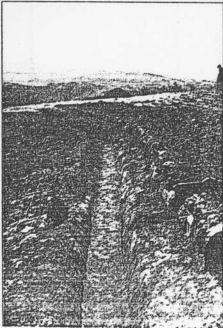
Foto 26. Sedimentador lleno de sedimento
