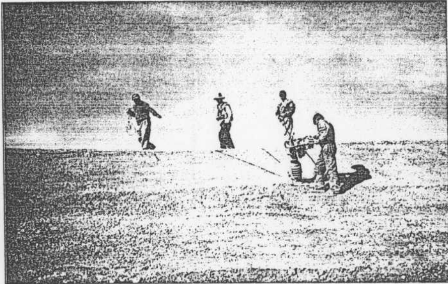
Foto 10. Compactación del talud interior
