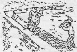
5. Construcción del drenaje periférico
