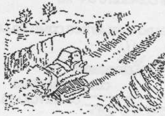
2. Construcción de la vía de acceso interna
