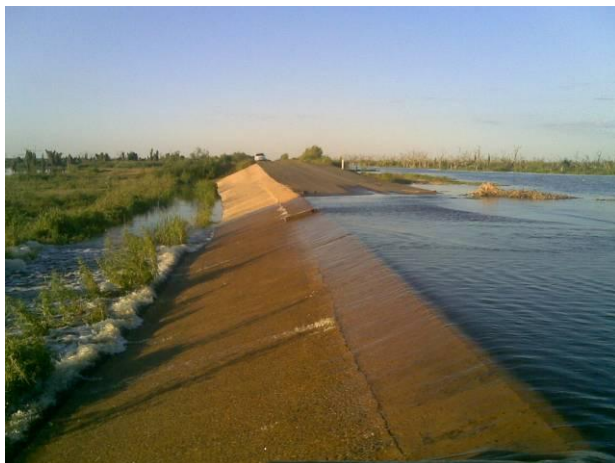
Figura 52: Foto Vertedero hacia el Sur.
