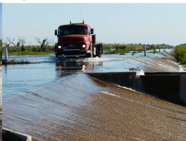
Figura 55: Zona de Compuerta.
