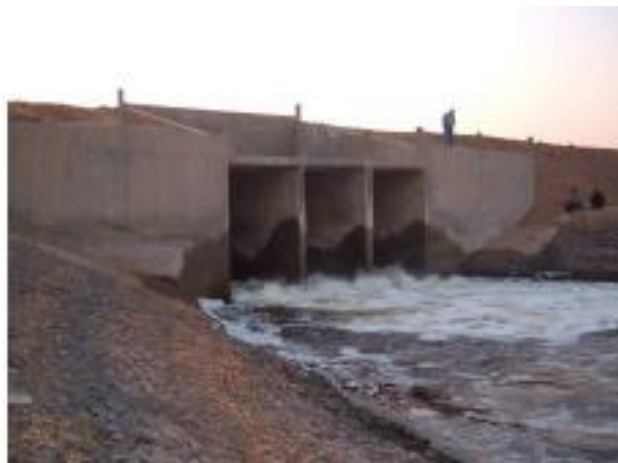
Figura 57: Zona de Compuerta. Fuente: Evarsa
