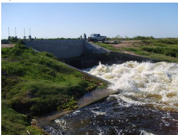
Figura 54: Zona de Vertedero.
