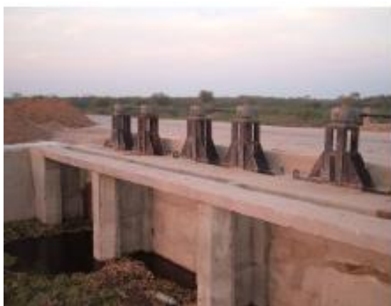
Figura 56: Zona de Vertedero. Fuente: Evarsa
