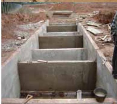
Floculador para aireación del agua de los estanques
