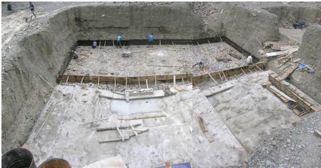
Tareas ejecutadas en los sedimentadores. En uno de ellos ya se vaciaron las losas de hormigón ciclópeo inferior y hormigón ciclópeo superior y en el otro se empedró y encofró para realizar el vaciado de la base H°C°. En la zona de los humedales se distribuyó el material para impermeabilizar los mismos (arcilla). Las cámaras de ambos ya se encuentran empedradas y en proceso de armado. Marzo/2007
