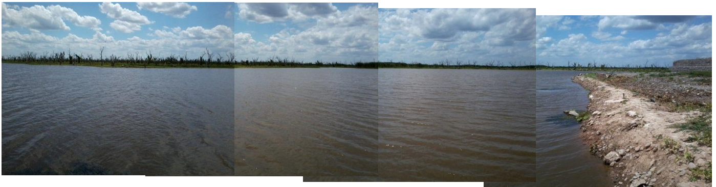
Foto 32. El Bañado La Estrella aguas arriba del vertedero
