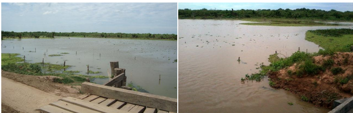
Foto 34 y Foto 35. Gral. Díaz, aguas abajo del puente, 2011 (izq), 2012 (der).
